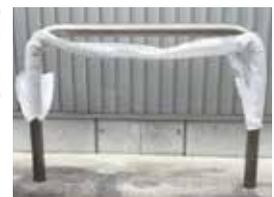
施工位置に穴を開け固定する際、両側の固定部の梱包材を約400mmまくり上げ、上の直線部は水平を出すためにコーナー部まで梱包材を開き下げておき、固定された後、梱包材をまた掛け戻します。
